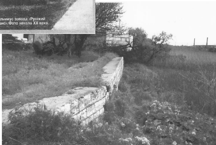
Сохранившаяся причальная стенка пристани завода «Русский Провиданс» на реке Кальмиус. Фото 2008 г.
