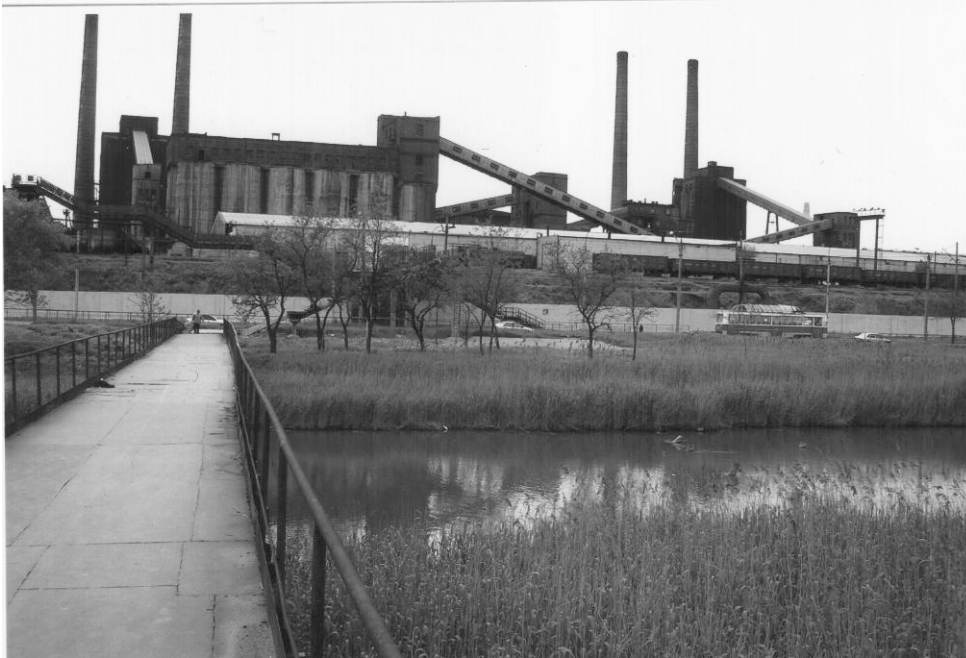
Пешеходный мост через р. Кальмиус
